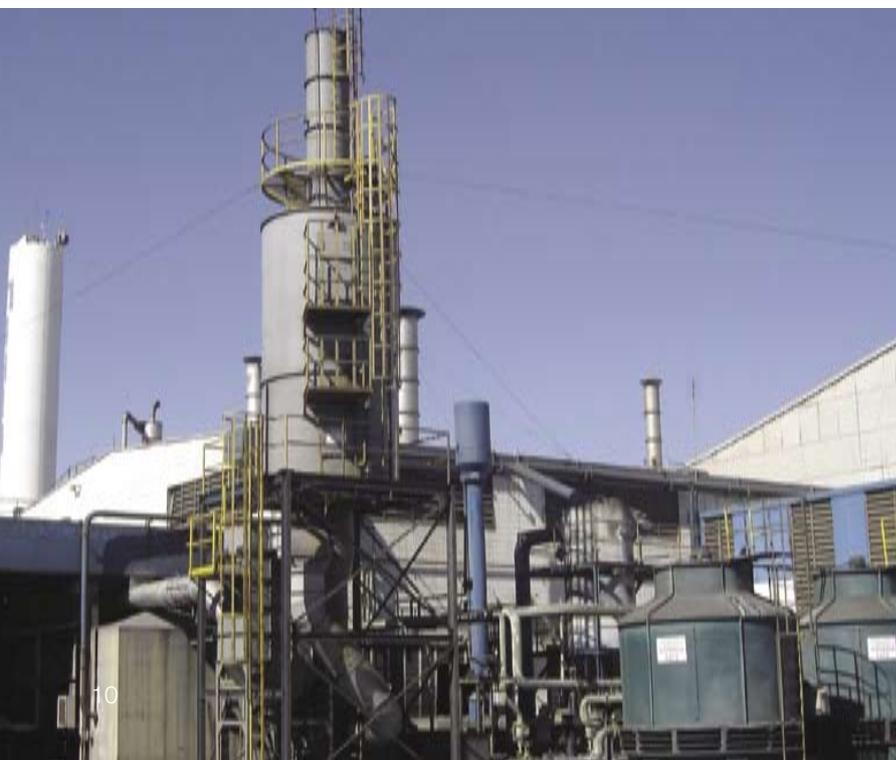
O processo de quebra química do óleo consiste na separação entre água (96%) e óleo (4%). A água é enviada para posterior tratamento na Estação de Tratamento de Efluentes (ETE) e descartada conforme exigências da legislação ambiental. O óleo recebe outras destinações finais específicas, autorizadas pela CETESB (Companhia de Tecnologia de Saneamento Ambiental).
