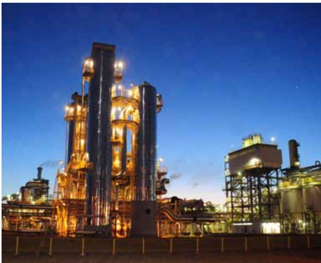
Por meio da queima do bagaço da cana, é gerada a energia elétrica utilizada em todas as usinas da Cosan Açúcar e Alcool.
